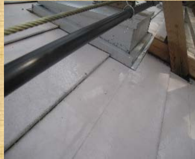
散水シャワー(鋼板屋根にタイマーで打ち水)
