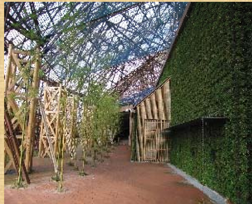
南壁面の壁面緑化(正面竹扉は機械室)
