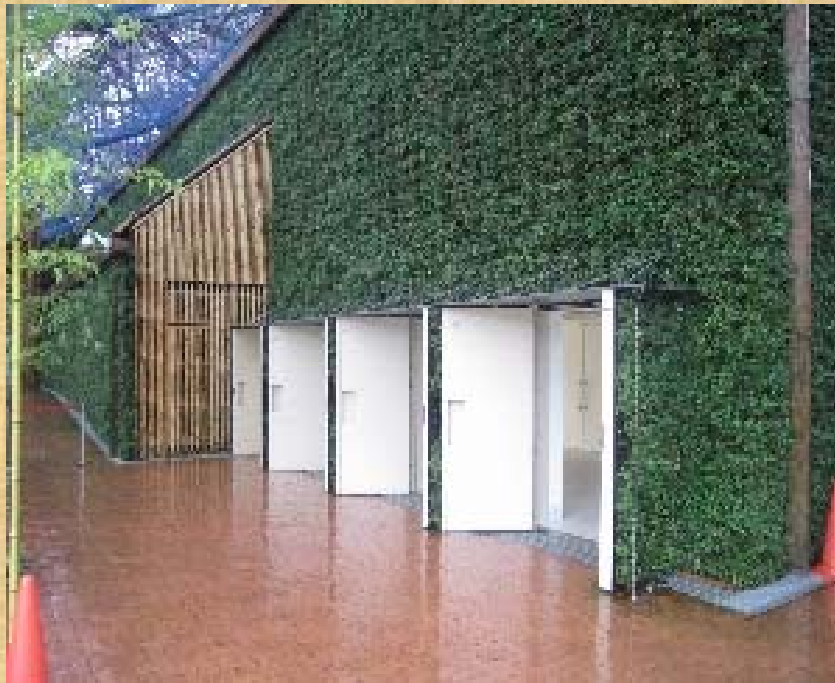
壁面緑化(南壁・出口)
