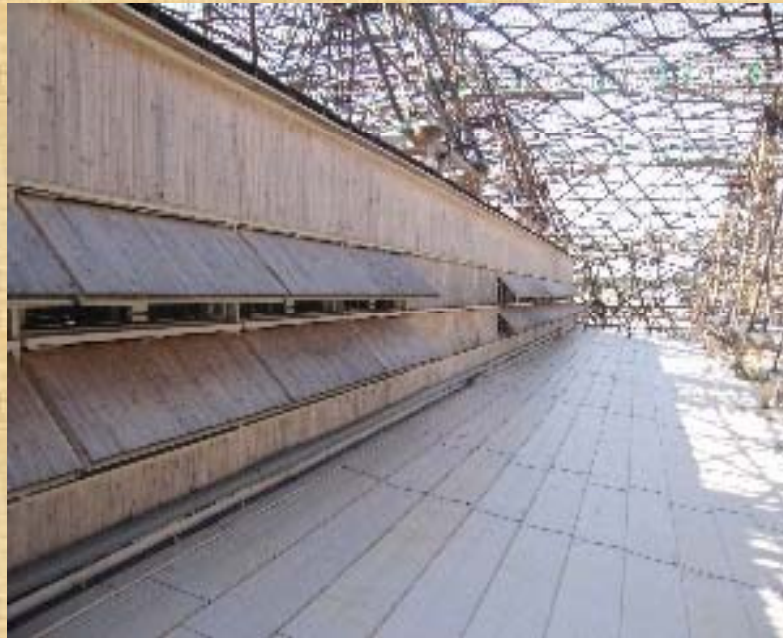
小屋裏の熱気を排気する跳上窓と、 屋根を覆う竹ケージの日陰効果
