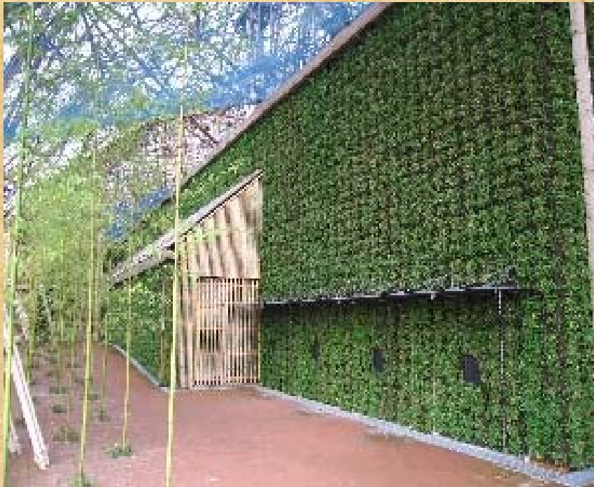
壁面緑化(南) ※閉扉時
