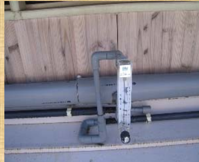
散水シャワー(鋼板屋根にタイマーで打ち水)
