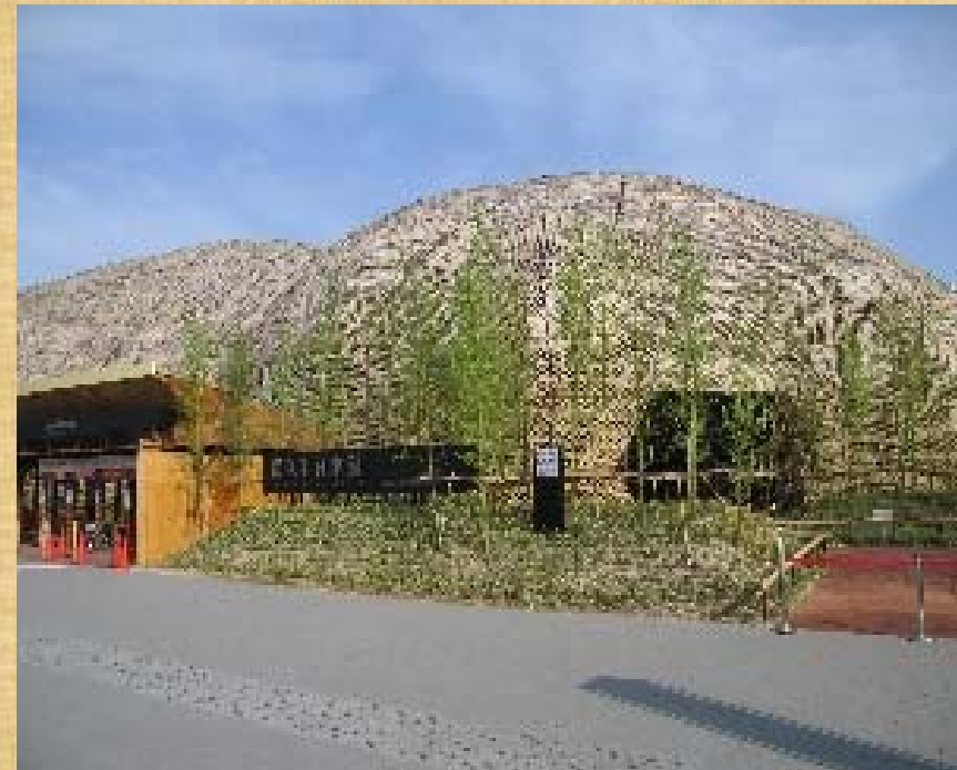
竹ケージ外観(出口廻り)
